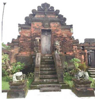
Gambar 2. Kori Agung yang terdapat di Puri Kaleran merupakan pintu masuk utama Puri Kaba-Kaba. Secara struktural, Kori Agung terdiri dari struktur atap, struktur badan, dan struktur kaki yang dibangun menggunakan batu bata dengan arsitektur vernakular tradisional Bali. Dalam konsep arsitektur tradisional Bali, utama mandala umumnya dibangun mengikuti konsep gunung – laut. Terdapat 7 buah anak tangga pada Kori Agung Puri Kaleran agar bangunan tersebut lebih tinggi dari bangunan lainnya yang menandakan kesakralan dari bangunan tersebut. (Sumber : Dokumentasi Peneliti, 2018).
