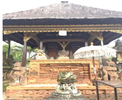
Gambar 3. Untuk mempertahankan kekuatan fisik dari bangunan puri, keluarga puri dan Balai Pelindungan Purbakala Provinsi Bali melestarikan bentuk bangunan dengan merestorasi tanpa mengubah susunan dan bentuk arsitekturnya. (Sumber : Dokumentasi Peneliti, 2019)
